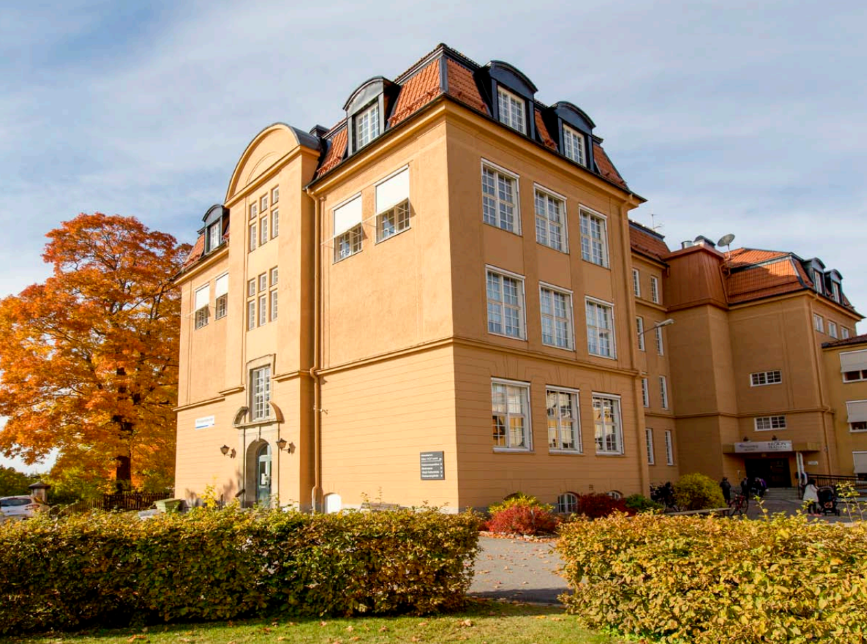
Ringsbergsskolans entré från sydost
