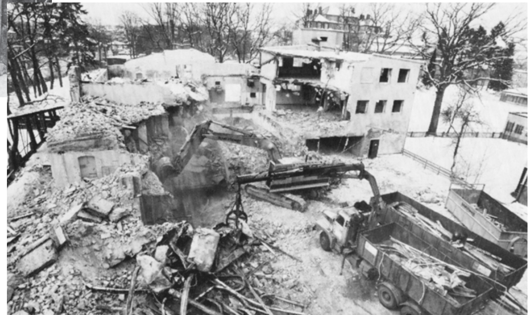
En del av bryggeriet revs 1984, jäskammare under byggnaden bevarades
